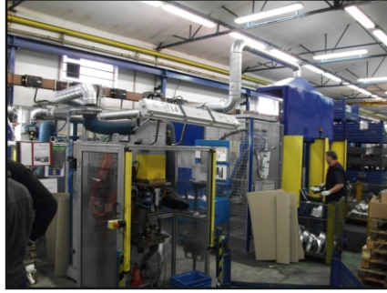
.... na obrázku jsou odsávaná pracoviště pro odporové svařování - robotizované pracoviště a ruční odporové lisy pro výrobu dílců pro automobilový průmysl.
