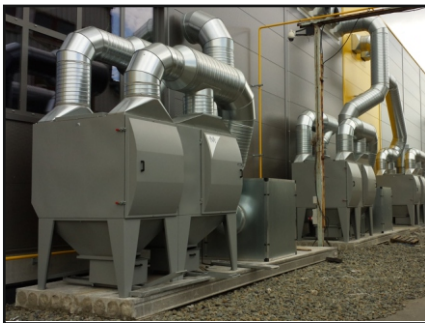
TŘÍDIČ, Šternberk - odsávání svařovny, pálírny a skladu materiálu systémem TCL. Velikost haly je 160x60 m.
