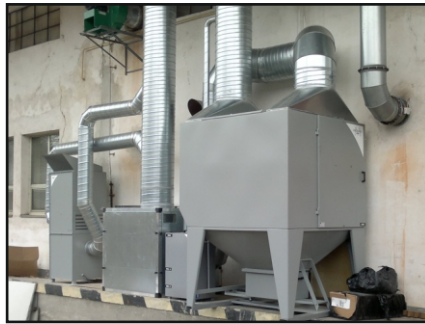
BAUMÜLLER BRNO, s.r.o., Skalice nad Svitavou - filtrační jednotka GM9V pro odsávání 6 samonosných ramen, jednoho svařovacího stolu a jedné horní digestoře.
