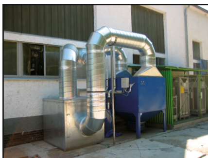
MASSAG Automotive, Fulnek - filtrační jednotka GM9V pro centrální odsávání dvou robotizovaných pracovišť, které svařují metodou MAG a 4 pracovišť pro odporové svařování...
