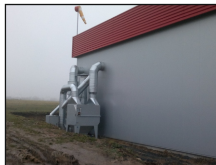
Strojárna Litvínov - filtrační jednotka GM9V pro centrální celoplošné odsávání haly systémem TCL.
