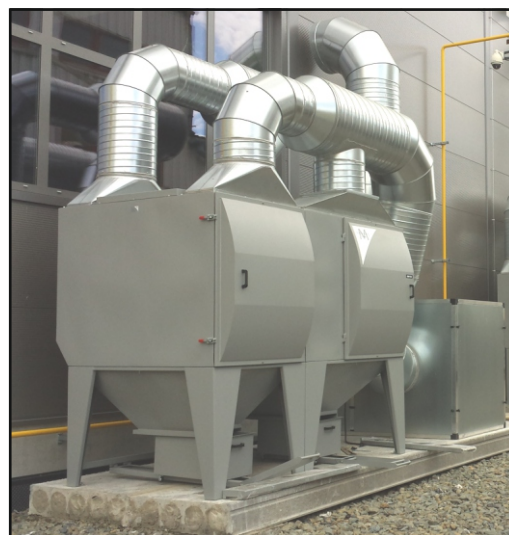
Typická středopodtlaková filtrační jednotka pro odsávání velké svařovny.
