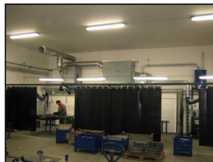
HON - kovo, Skřipov - filtrační jednotka GM3V pro odsávání čtyř ručních svařovacích pracovišť při výrobě kovového nábytku.
